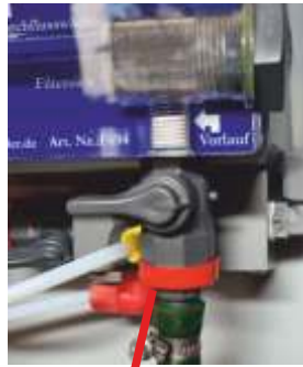
Kugelhahn ist geschlossen
